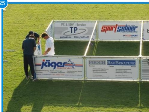
Letztes Stirnteil „KWE“ einsetzen, im 90° Winkel ausrichten und verschrauben.
