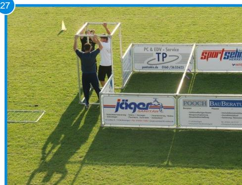
Deckel des linken Tores aufsetzen und die Madenschrauben am Tor mit der Inbusrätche handfest (max. 40 Nm) anziehen.
