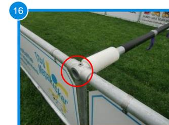
16 Die Querrohre nach außen bündig zur Bande abschließen lassen.
