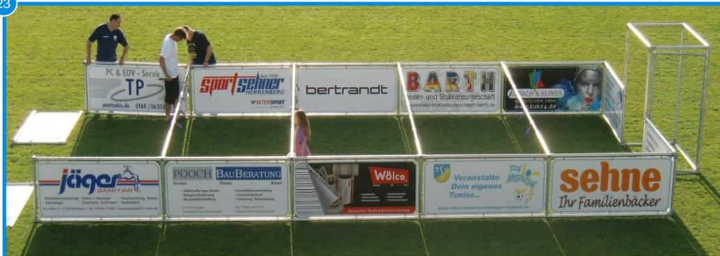
Seitenteil „Pantzakis“ und „Jäger“ einsetzen und in Linie ausrichten. Die Madenschrauben anziehen.
