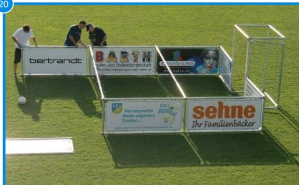
Seitenteil „Bertrandt“ einsetzen und in Linie ausrichten.
