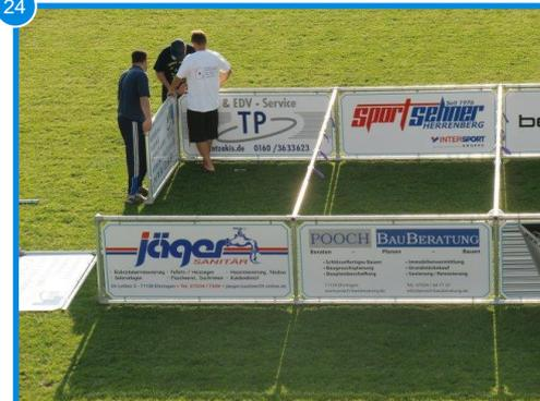
Stirnteil „KWE“ einsetzen, im 90° Winkel ausrichten und verschrauben.
